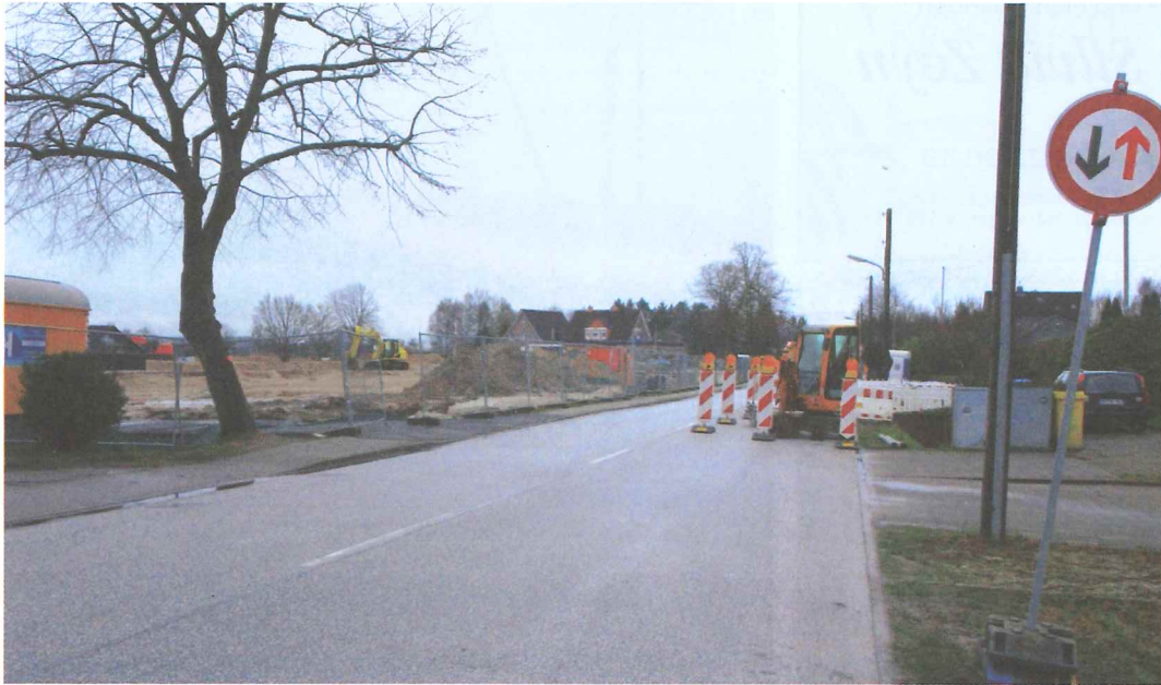
Vor der Baustelle der neuen Stadtteilschule regeln Schilder und temporäre Ampeln den Straßenverkehr auf der einen freien Fahrbahnseite des Kirchenheerweges. Foto: Gundula Klämt
