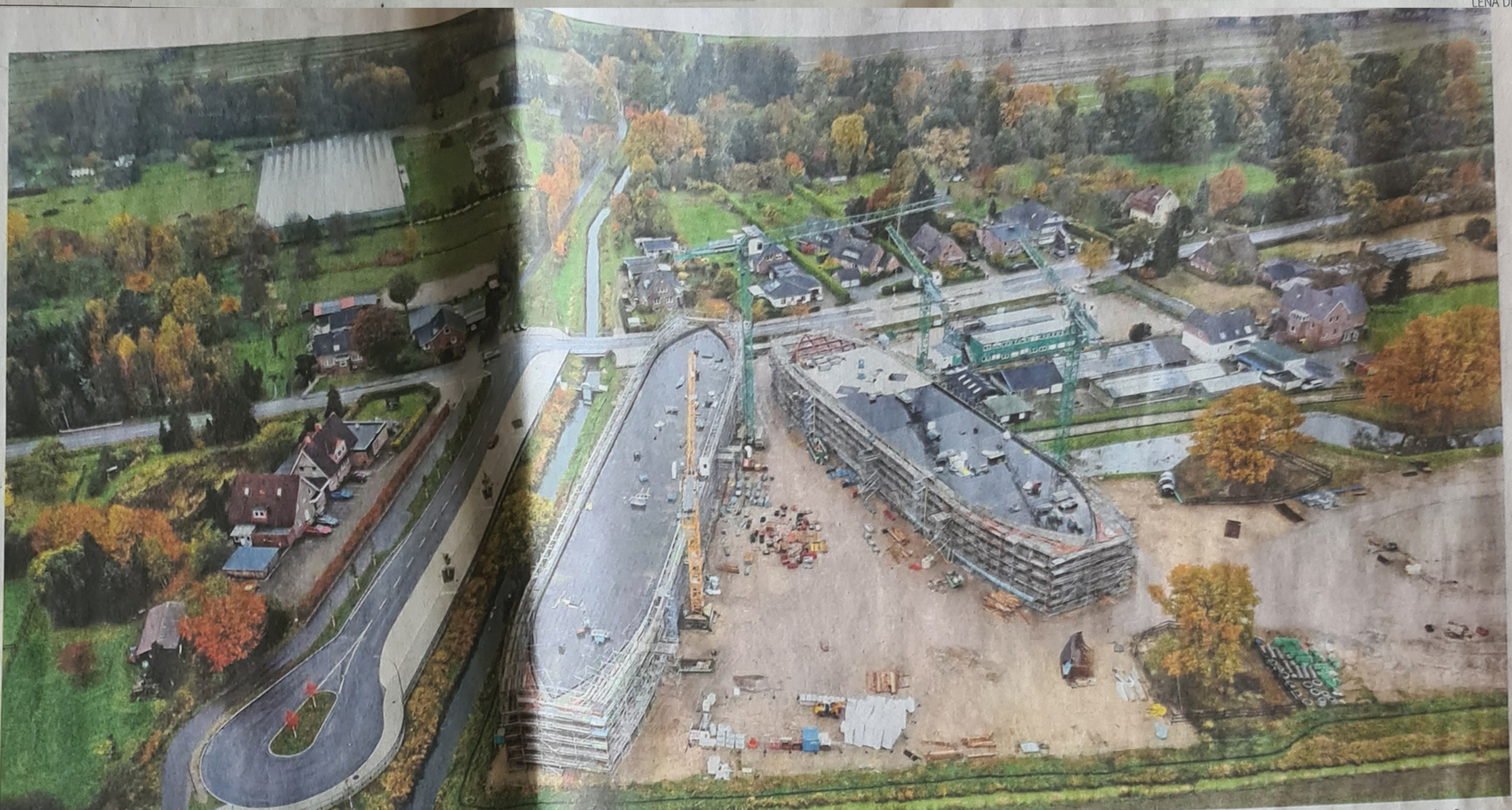
Die neue Stadtteilschule Kirchwerder aus der Vogelperspektive: Der Rohbau für die beiden langgestreckten Schulgebäude und die Sporthalle (r.) ist fertig. Auch die Buskehre auf dem Marschbahndamm (l.) ist bereits fertiggestellt.
