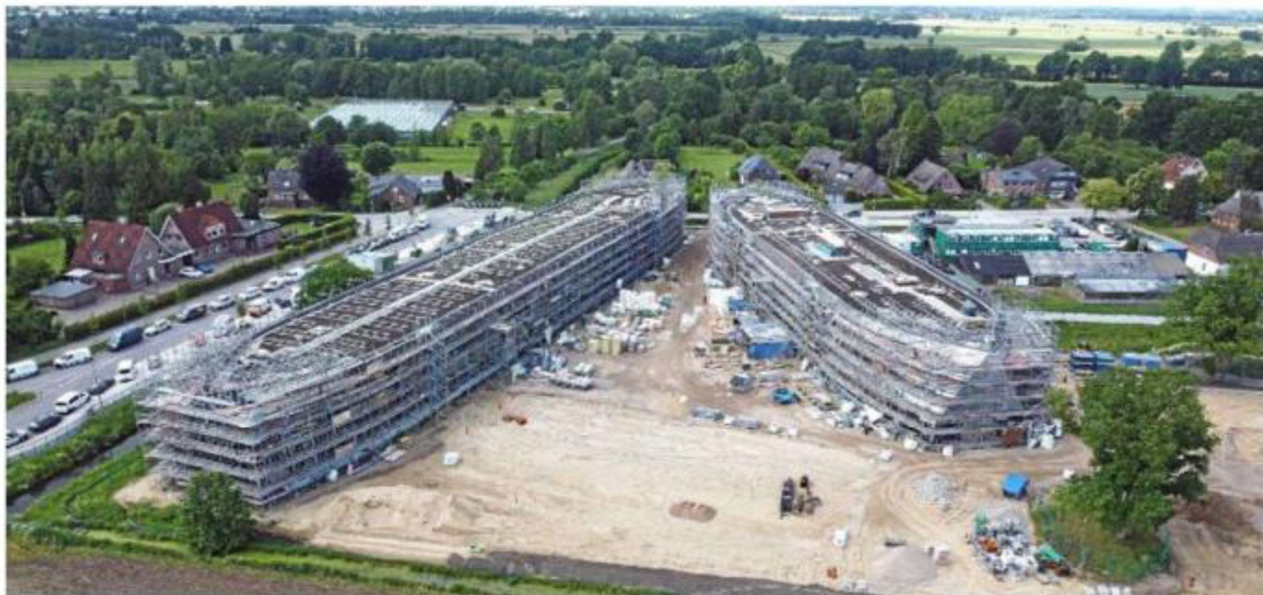
Luftaufnahme aus den letzten Mai-Tagen: Noch ist der Neubau am Teufelsort komplett eingerüstet.
